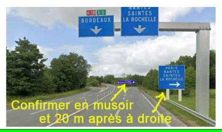
**Préconisation N°** IIIIII Dans les échangeurs trompette, il faut compléter les signalisations sur potence ou portique qui, selon les circonstances ne sont pas visibles (nuit, pluie, brouillard, soleil, feux de croisement), pour cela il est IMPÉRATIF de re-signaler les directions sur le côté 20 m la après la potence ET sur le musoir. À 60 km/h dans l'échangeur, une hésitation au musoir est moins dangereuse qu'un accident de contresens à 130 km/h.
