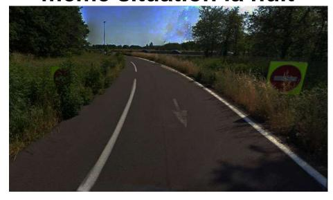
**Préconisation N°** IIII - Pour définir l'aménagement et la signalisation, sur les bretelles de sortie, il faut se projeter dans les conditions extrêmes : que l'herbe pousse, qu'il fait nuit, que le conducteur est alcoolisé, fatigué, inexpérimenté, optimiste
