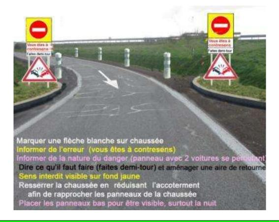
**Préconisation N°** Influencer le conducteur à ne pas continuer sur la bretelle de sortie en <u>réduisant l'accotement</u> par une oreille bordurée afin de rapprocher les panneaux de la chaussée pour qu'ils soient bien dans le champ visuel d'un conducteur, et impactent fortement les conducteurs <u>même ivres</u> et même de nuit.
