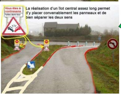
**Préconisation N°** IIIIII - Réaliser, pour les accès aux voies express, un îlot central assez long afin de pouvoir y placer convenablement les panneaux et pour bien séparer la chaussée « entrée » et la chaussée « sortie ».
